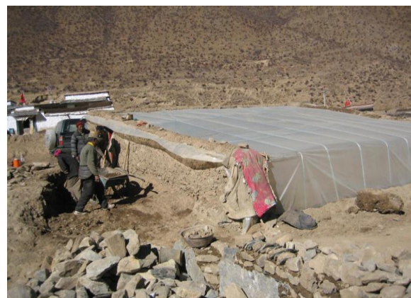
De kas in aanbouw
