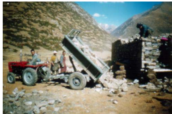
Bouw van de school in Kartam
