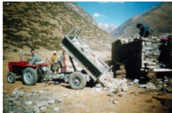
Bouw van de school in Kartam
